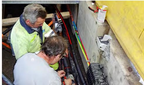
**Netzcrew beim Erstellen einer Mittelspannungsmuffe.**
