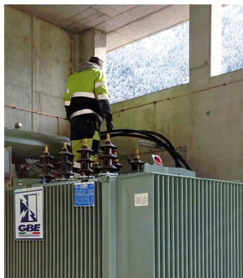
**Anschluss des 3,4-MVA-Transformators.**
