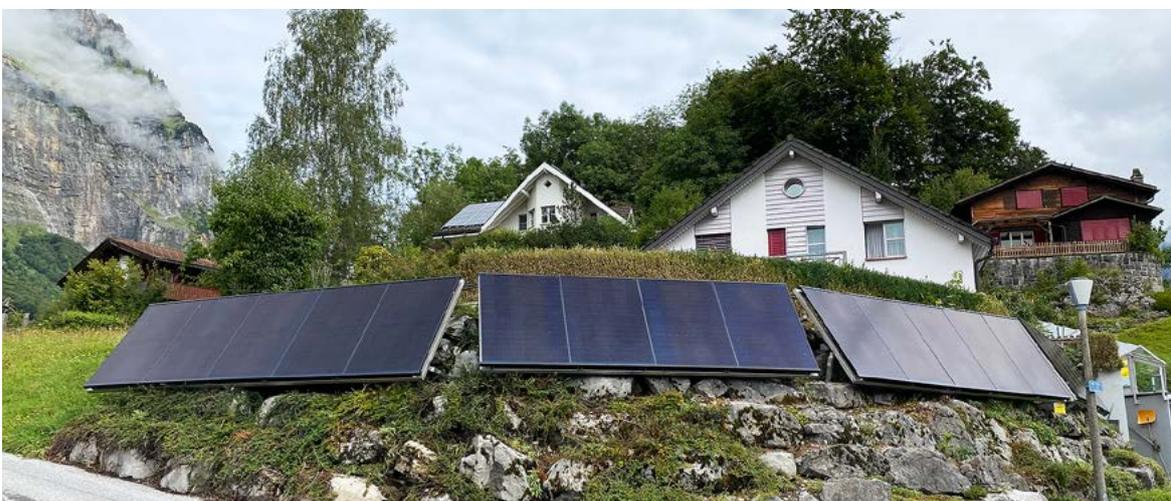
**Photovoltaik-Anlage an einer Stützmauer in Schwändi.**
