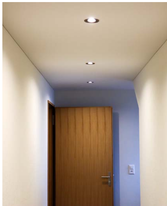
Elektroinstallationen im Flur.
