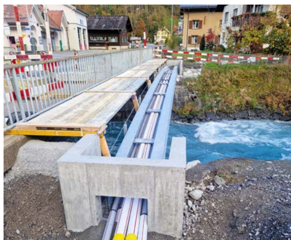
Neue Werkleitungsbrücke über die Linth in Linthal.
