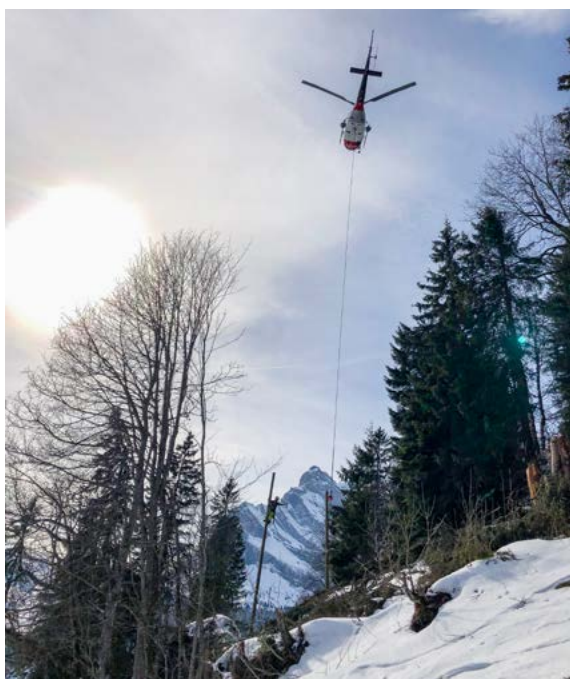
Netzarbeiten mit Unterstützung aus der Luft.
