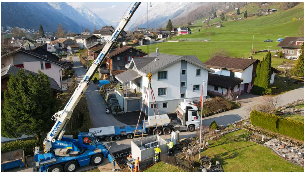
Ersatzneubau TS Addacher Nidfurn.
