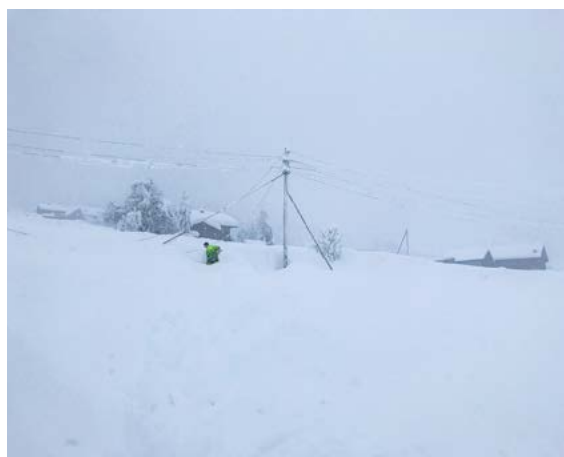
Reparatur-Arbeiten bei Schneegestöber in Linthal.
