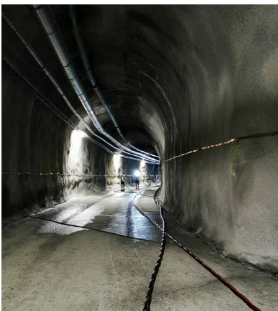
Kabelverlegung im Stollen.
