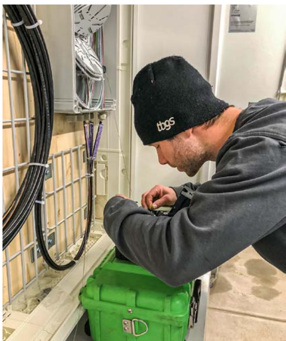
Mario Haller bei LWL-Spleissarbeiten für einen Kundenanschluss.
