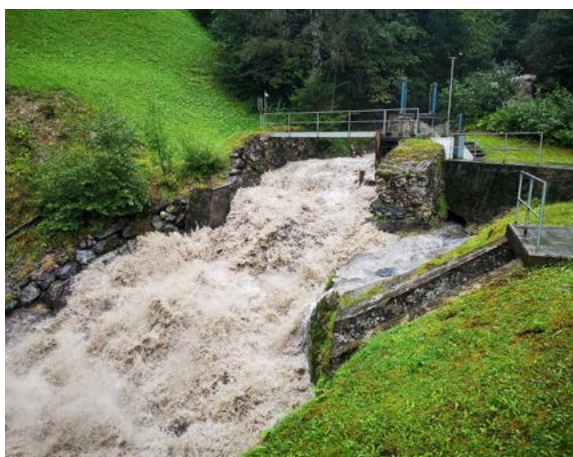
Hochwasser KW Krauchbach.
