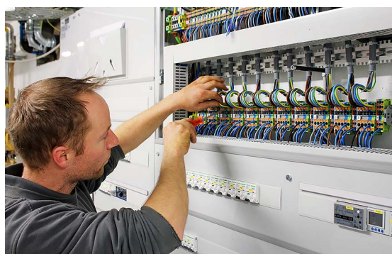
Tobias Luchsinger beim Anschluss der Wohnungszuleitungen.
