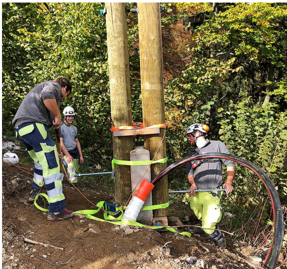
Anschluss der neuen Mittelspannungsleitung.
