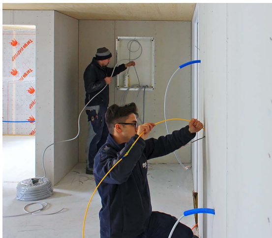
Jonas Bähler und Atilla Altunbas beim Einzug der Leitungen für die elektrischen Apparate.
