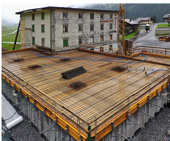
Rohbau der umfangreichen Umbauarbeiten.
