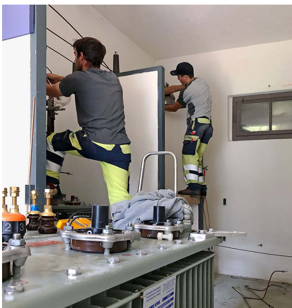
Sandro Zweifel und Remo Herter bei Abbrucharbeiten in der Trafostation.
