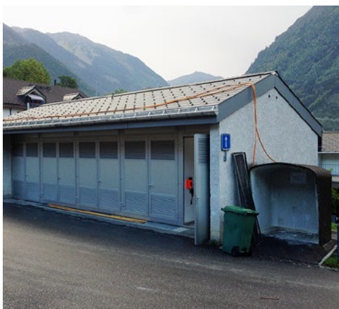
Sanierte TS Rüteli im neuen Kleid.
