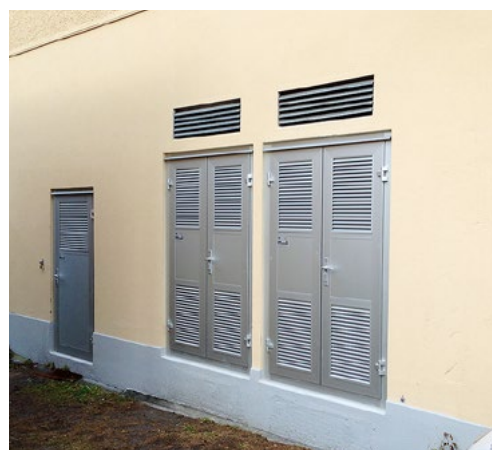
Neue Alu-Türen inkl. Lüftungsgittern.
