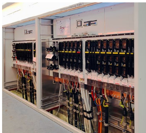
Niederspannungsverteilung.
