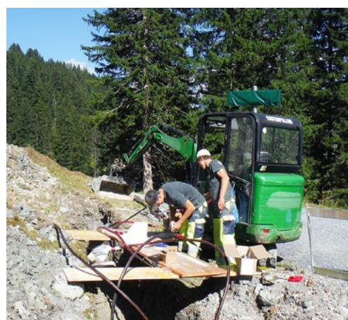
Netzcrew bei der Reparatur.
