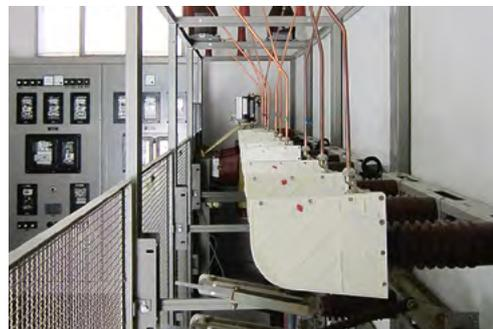
**Alte Mittelspannungsanlage: Die sichtbaren Kupferleitungen führen 16,8kV Spannung.**
