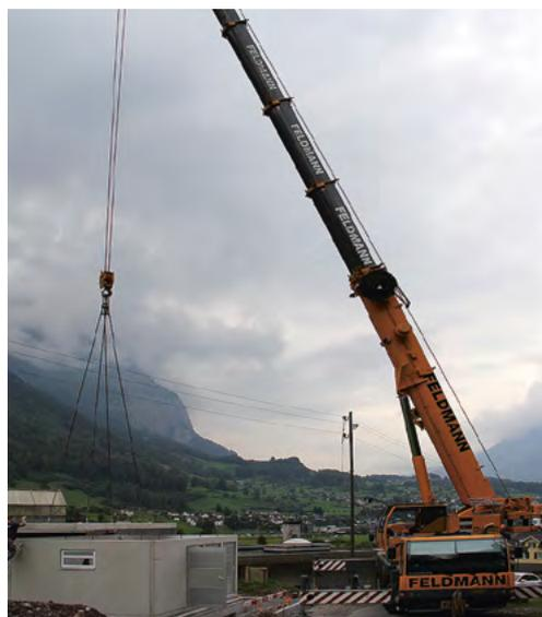
**Die in Elementbauweise gelieferte Transformatorenstation wird mit einem Pneukran aufgerichtet.**
