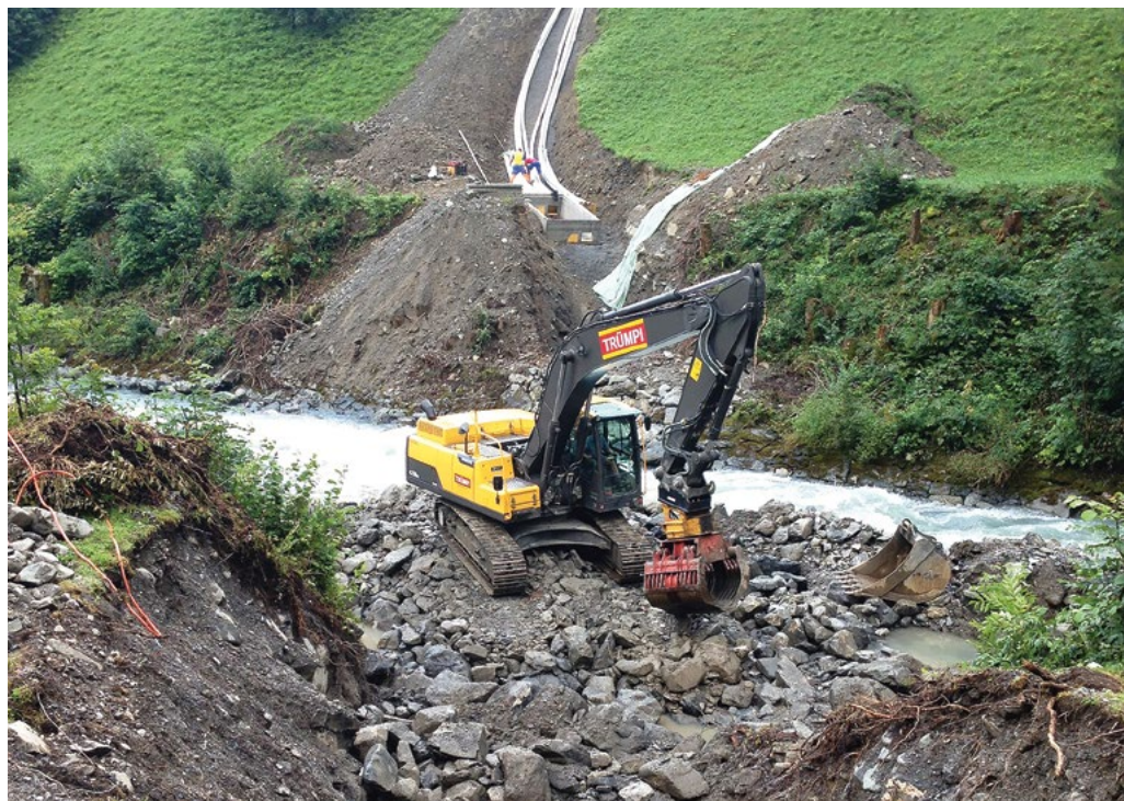
Linthquerung im Fätschli in Linthal.
