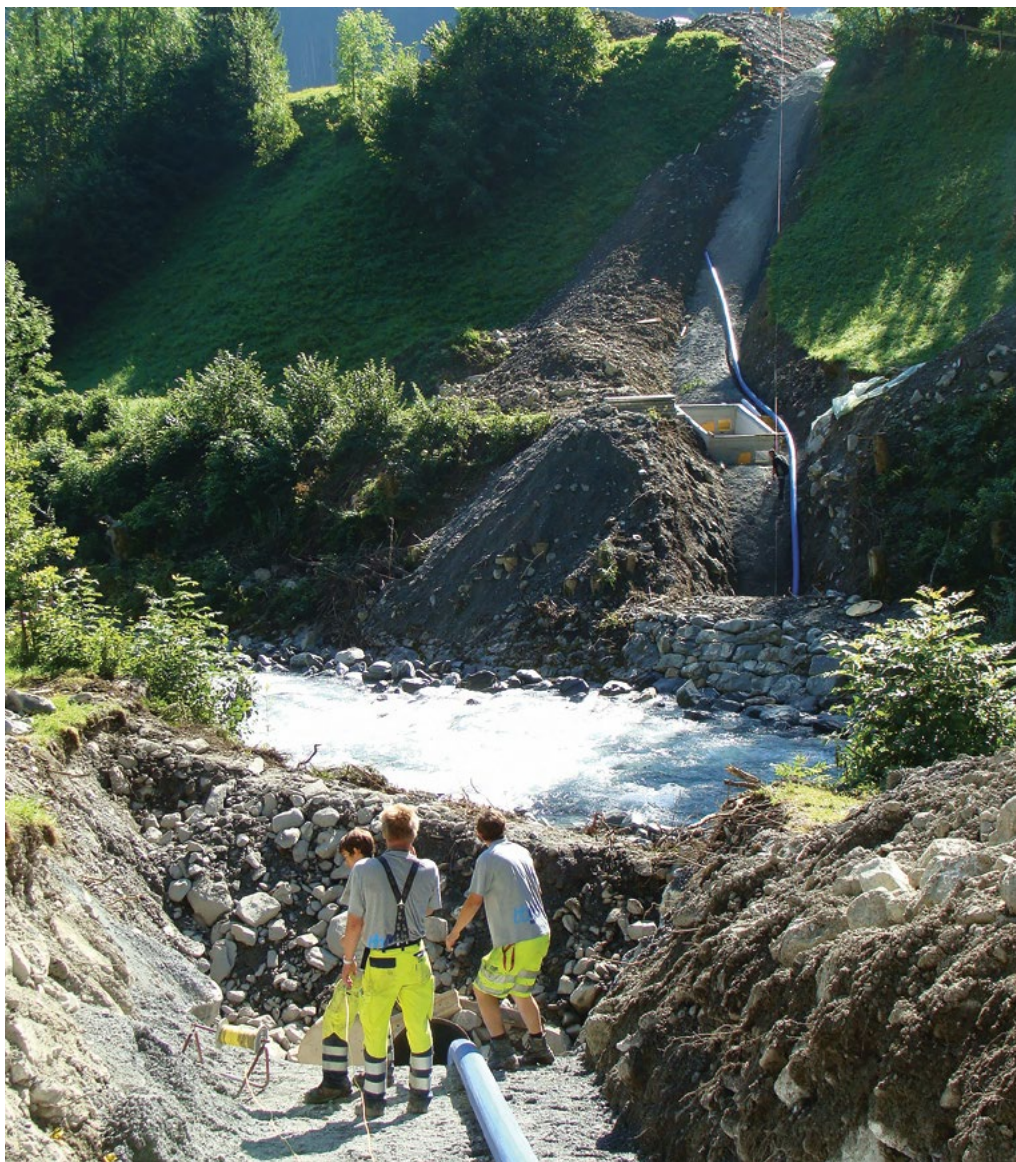
Einzug von Kabelschutzrohren und Hauptwasserleitung mit Zugwinde.
